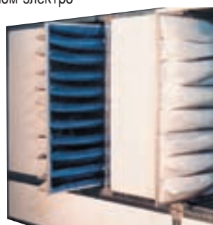
Кассетные фильтры агрегатной группы меняются в течение нескольких минут.
